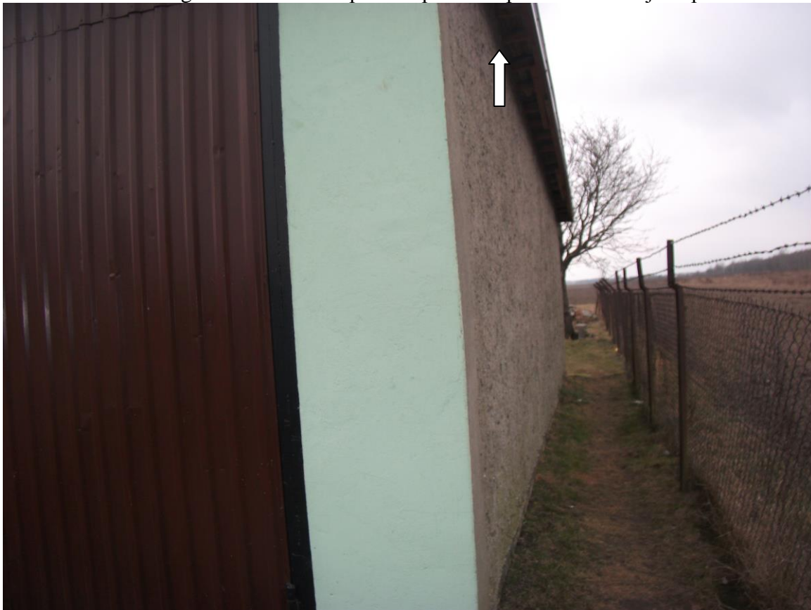
4.Sciana garazowa do docieplenia i podbitka połaci dachowej okapu.
