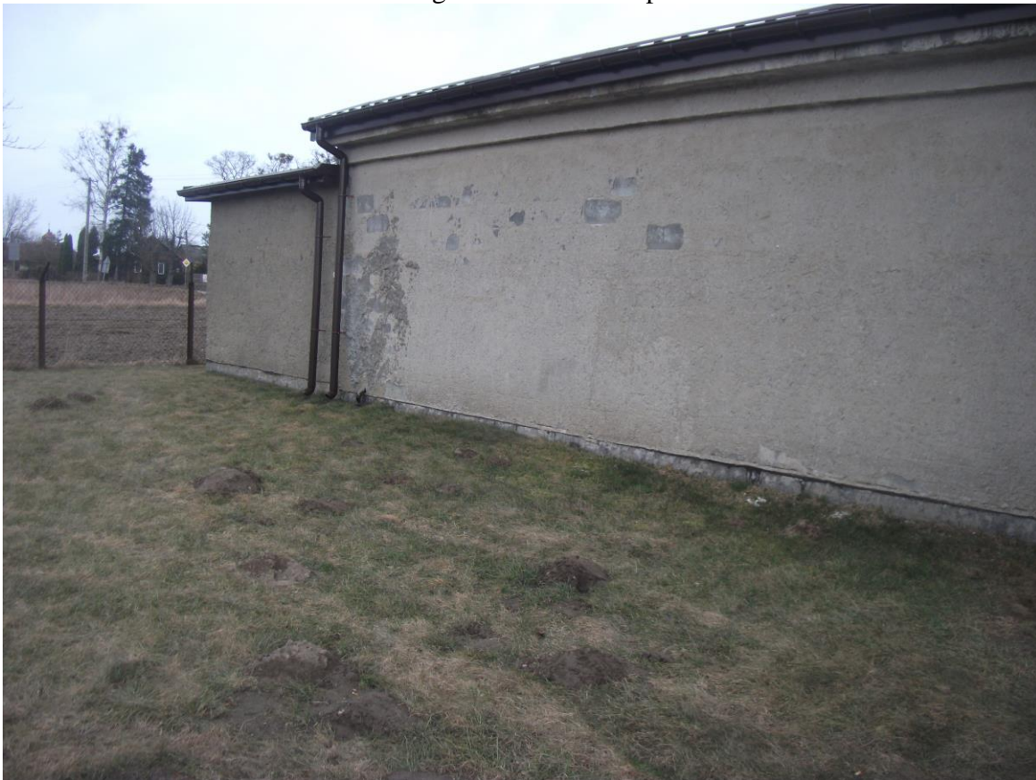
4.Sciana garazowa do docieplenia i podbitka połaci dachowej okapu.
