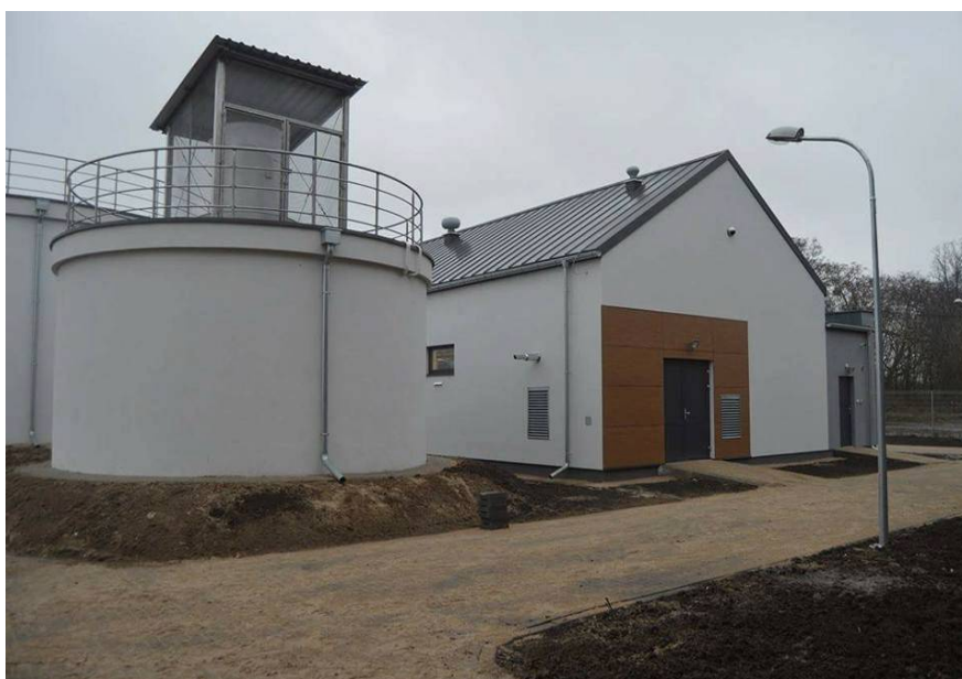
Fot. Urząd Miejski w Zakroczymiu Stacja Uzdatniania Wody w Henrysinie
