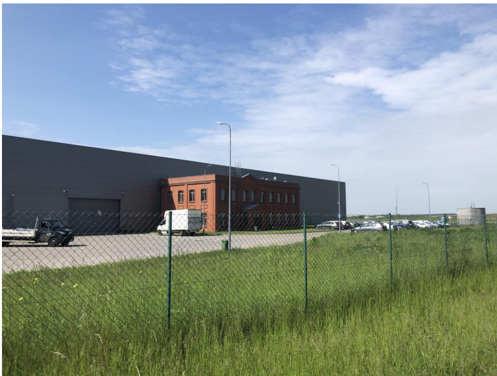
Fot. 2 Istniejąca zabudowa produkcyjna wzdłuż drogi S7
