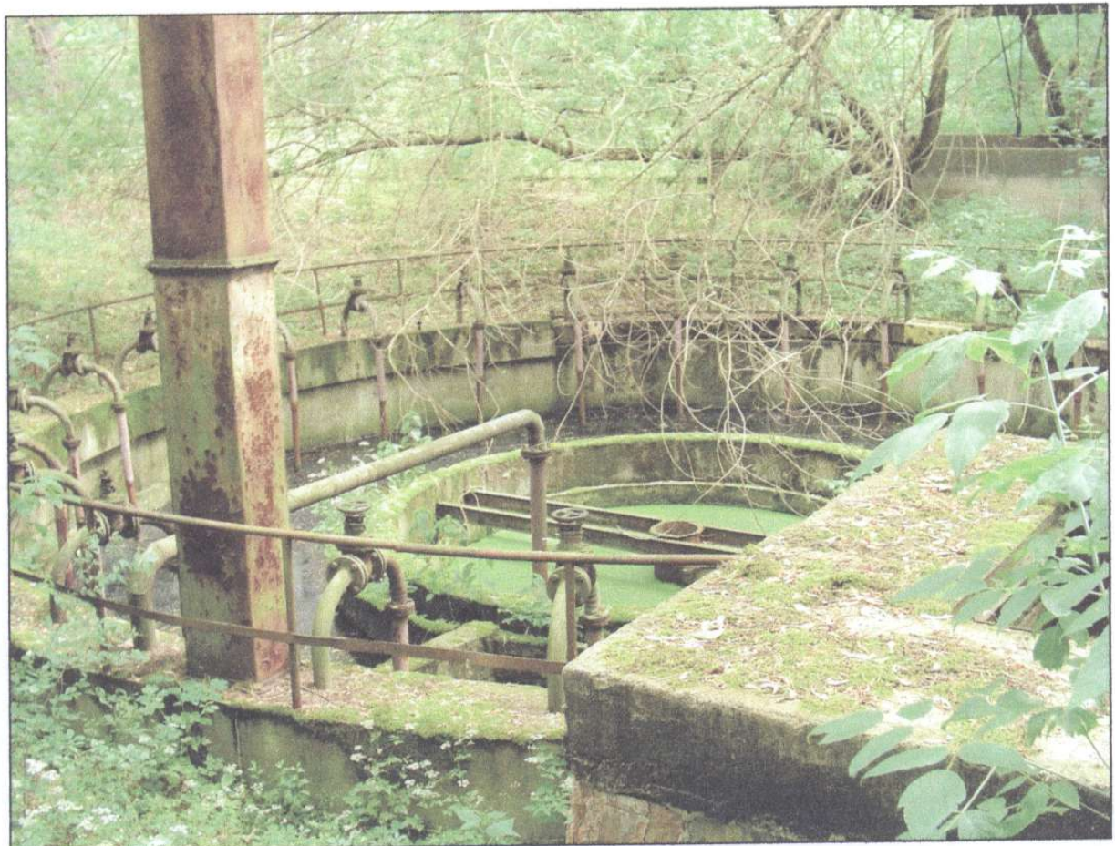
Nieczynna oczyszczalnia ścieków na terenie byłego ośrodka im. Róży Luksemburg.
