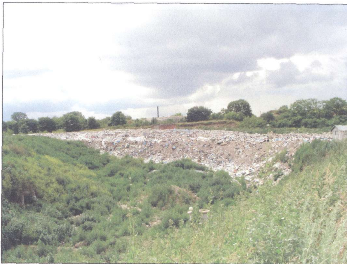
Składowisko odpadów komunalnych w Zakroczymiu.
